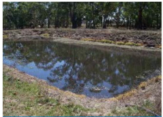
Foto tomada 4 meses después de la adición de LIQUIDATOR®
