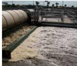
Figura 1. Formación de espuma antes de la dosificación con BIO GENESIS®
